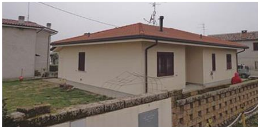
Ristrutturazione in villa unifamiliare a Ferrara
