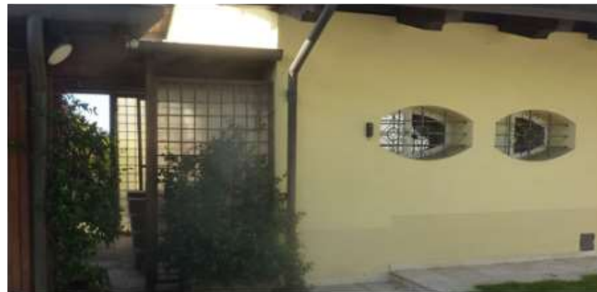
Ristrutturazione in villa unifamiliare a Vicenza
