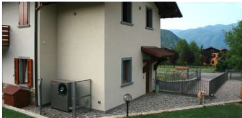
Ristrutturazione in villetta bifamiliare a Fino del Monte (BG)
