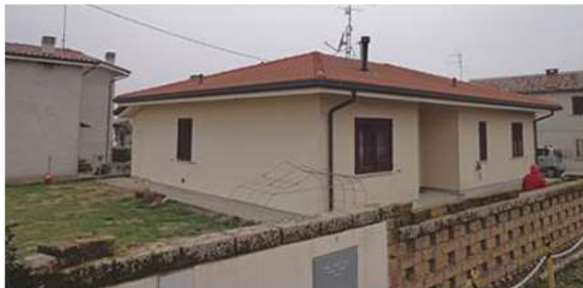
Ristrutturazione in villa unifamiliare a Ferrara
