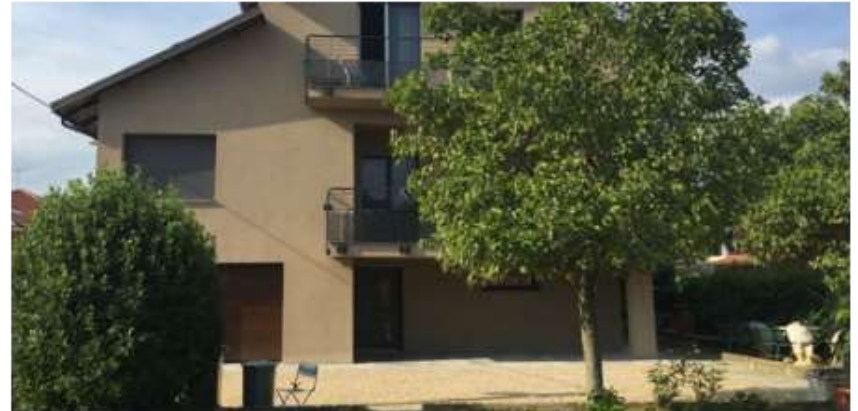
Ristrutturazione in villa bifamiliare a Candiolo (TO)
