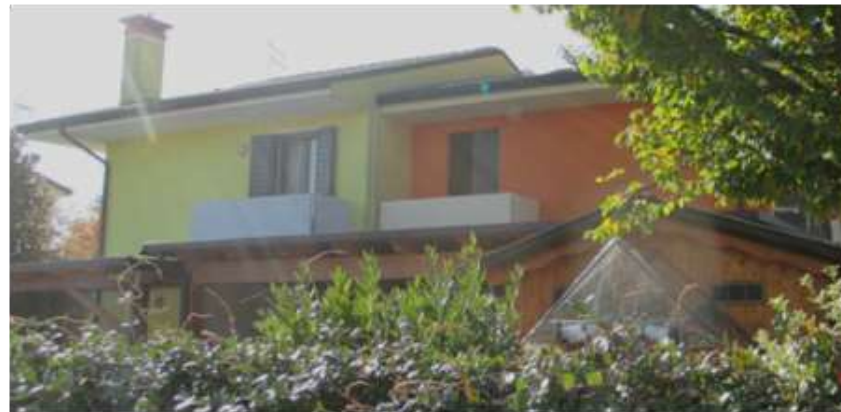
Ristrutturazione in villa unifamiliare a Padova
