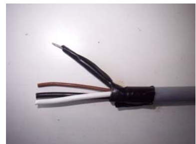
Détail Application du ruban isolant
