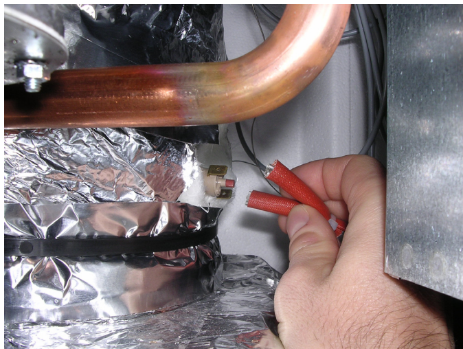
Figure 2 – Inspection du thermostat de sécurité du générateur
