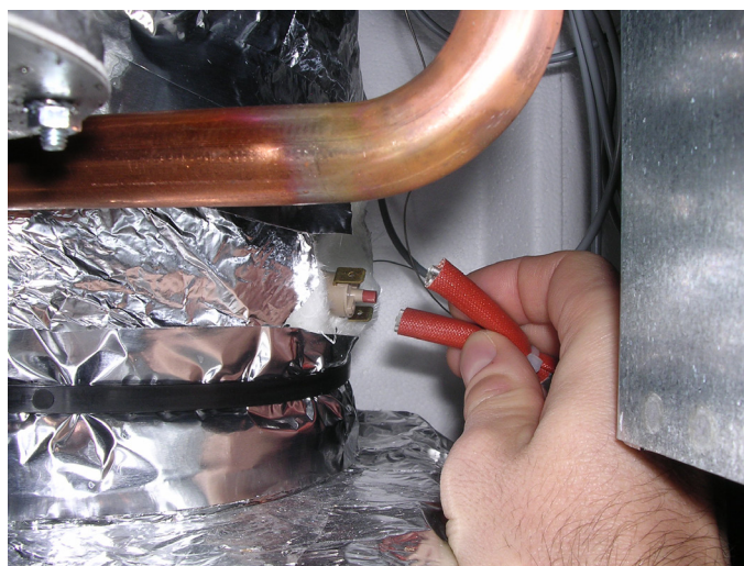
Figure 2 – Inspection du thermostat de sécurité du générateur
